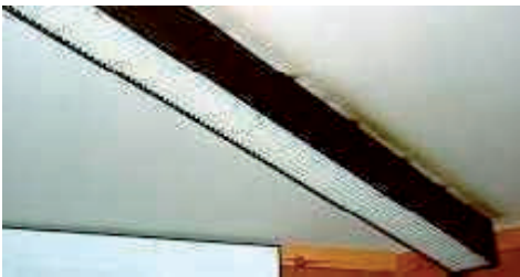
Diffuseur en micro-grille pertes = 75 %
