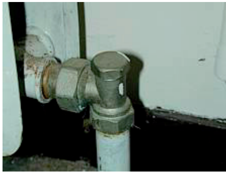
Té de réglage du débit d'un radiateur.
