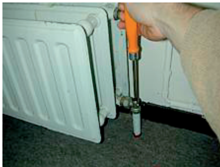
Té de réglage du débit d'un radiateur.
